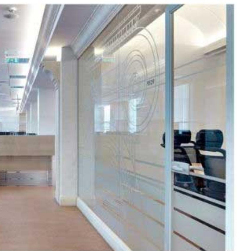
В основе цельностеклянных перегородок лежит конструкция, состоящая из листов закаленного стекла, которое прочно фиксируется в надежных зажимных профилях.
